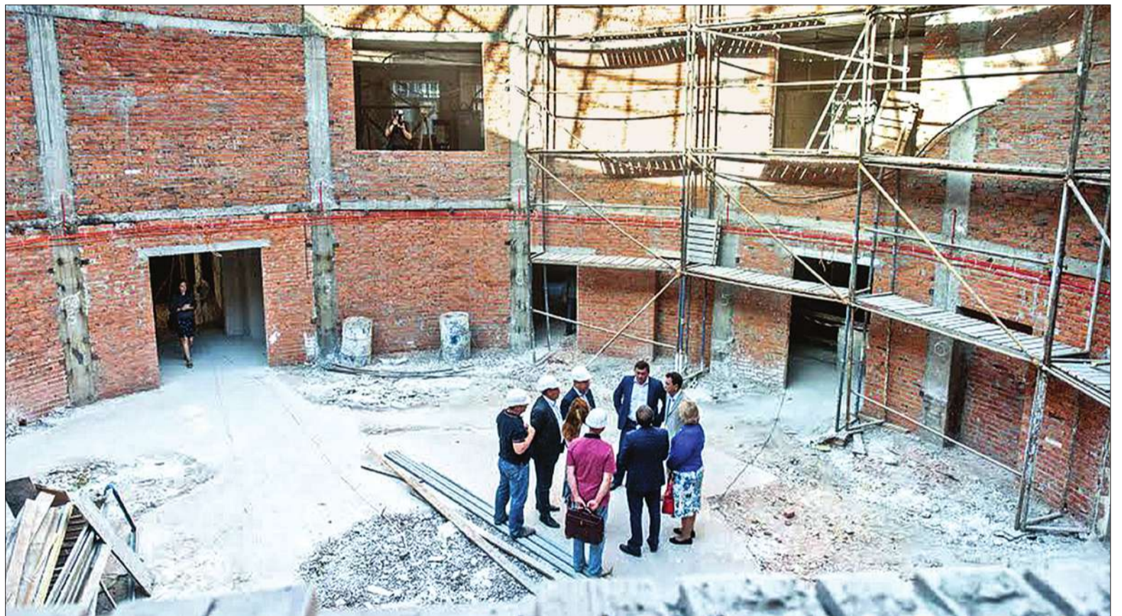
Учора відбулася інспекція будівництва на вул. Олени Теліги, 37-г Центру соціальної реабілітації дітей з інвалідністю та Територіального центру соціального обслуговування людей похилого віку
