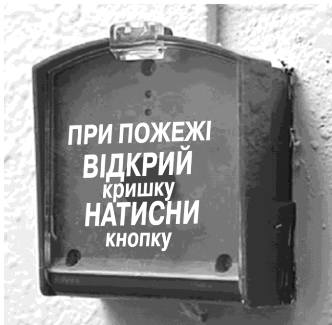
Рисунок 1 - Зовнішній вигляд ручного пожежного сповіщувача
