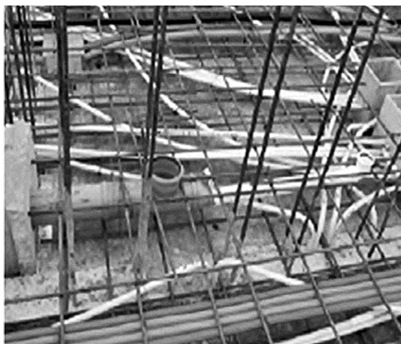
Рисунок 3 - Розміщення комунікацій в підготовці підлоги
