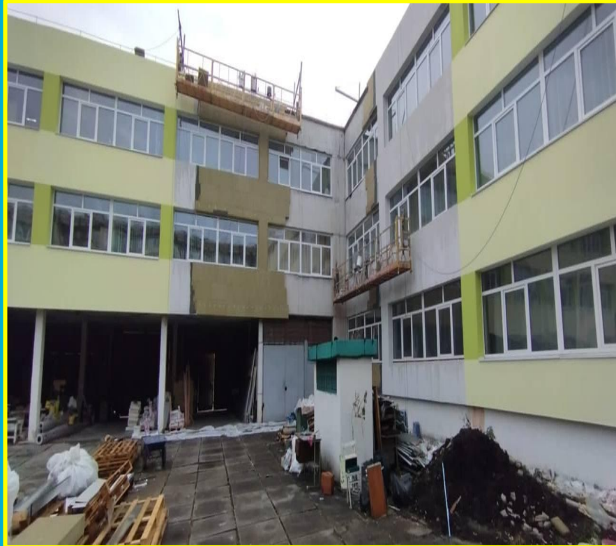
Школа 232 Роботи з утеплення фасадів
