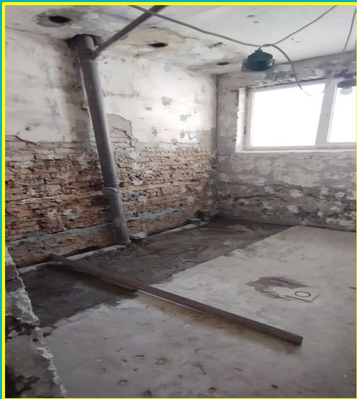
Школа № 14 Ремонт санвузлів
