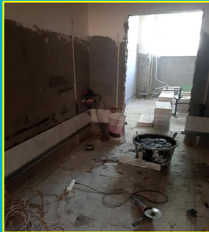
Школа № 285 Ремонт санвузлів
