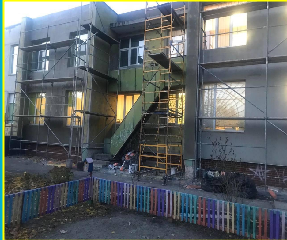
Школа 611 Роботи з утеплення фасадів
